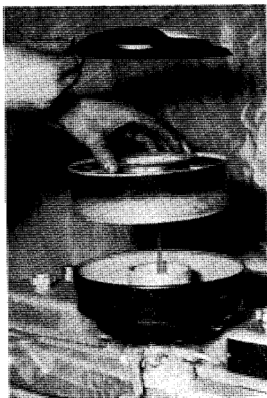
Afb. 16 Montage luchtfilterelement.
